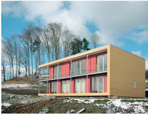
Bei Sonnenschein holen grosse Fensterfronten die Wärme in die Baumasse. Sonnenstoren schützen gegen Überhitzung.
