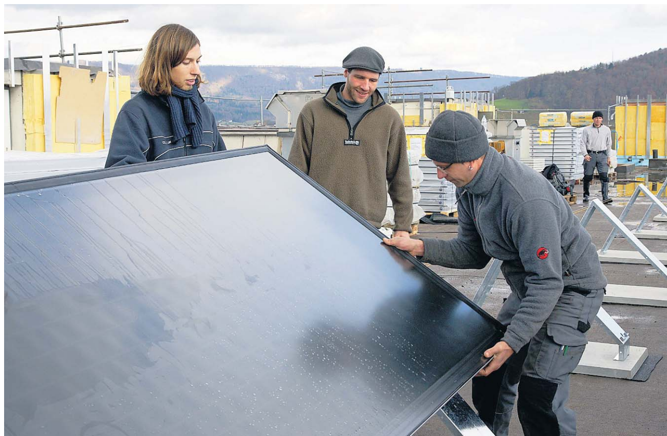
Profis helfen der Jugendsolar-Gruppe beim Platzieren der Sonnenkollektoren auf dem Dach. ANNA WANNER
