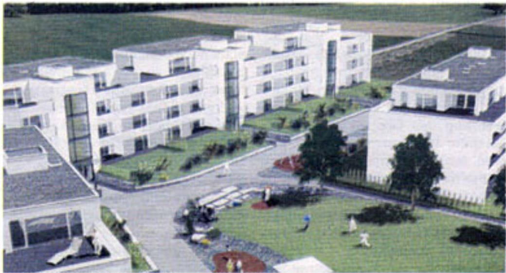
In Rütihof entsteht die Überbauung Steiachner.
