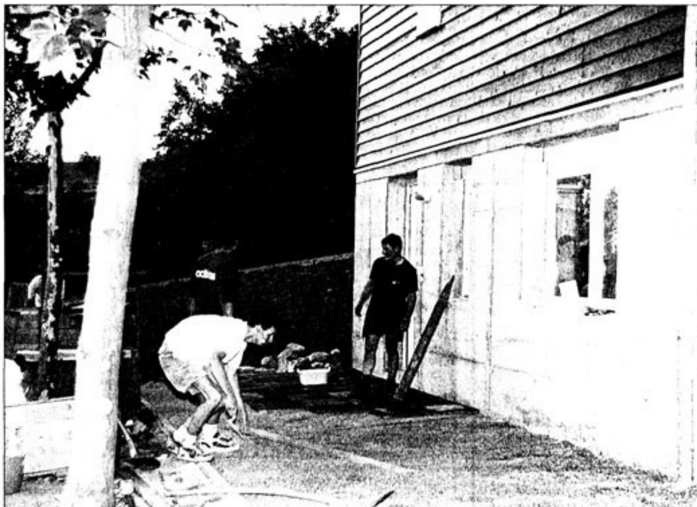
Noch gibt es einiges zu tun Unter fachkundiger Anleitung helfen die Jungschlarleiter bei den Arbeiten.
