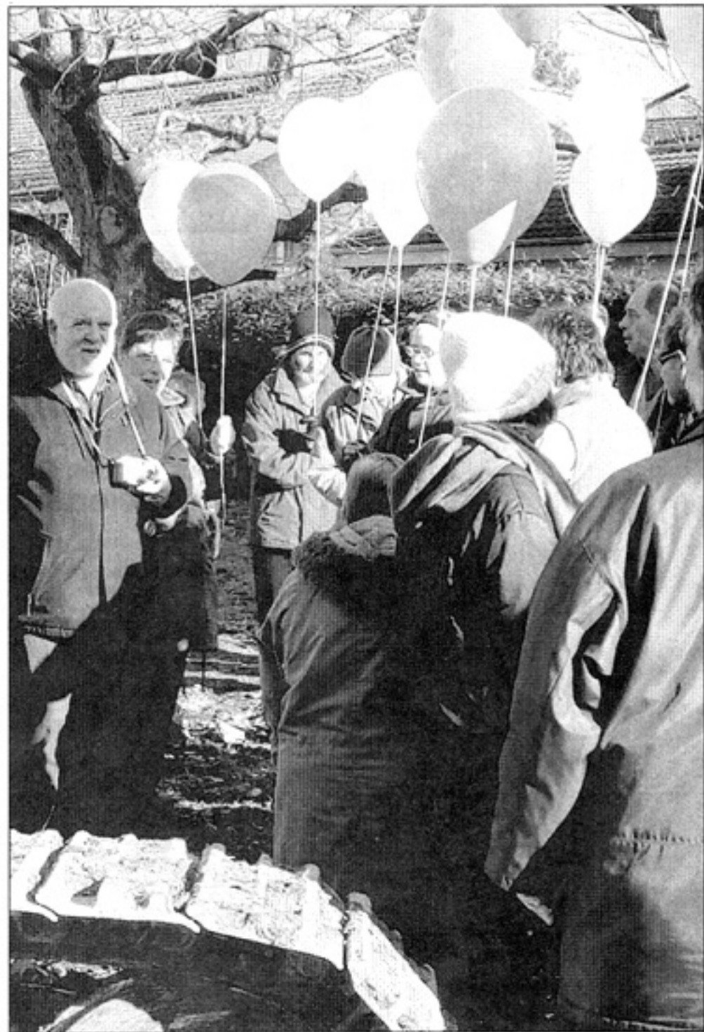
Neubau «Bifang»: Am Spatenstich wies Alfred Isch (l.) die Menschen mit einer Behinderung freudig an, Ballone fliegen zu lassen Foto: meb
